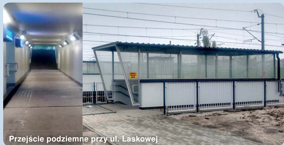
Przejście podziemne przy ul. Sikorskiego
